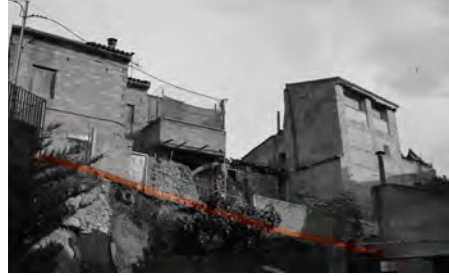
C Paso del agua bajo viviendas
